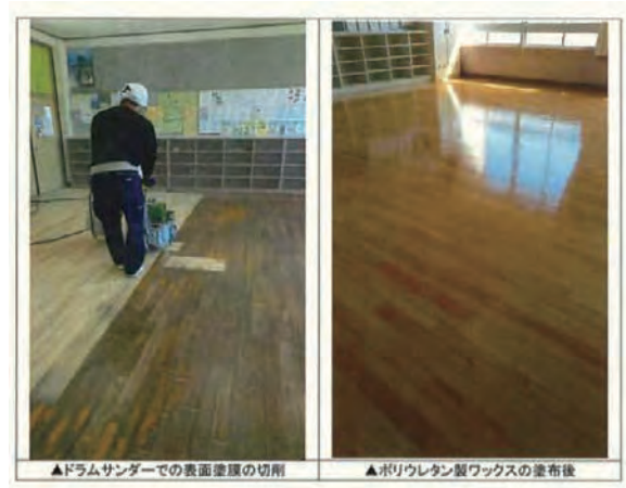
▲ドラムサンダーでの表面塗膜の切削
